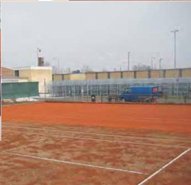
Während der Frostperiode wird durch Eisbildung die Kornverzahnung der Deckschicht aufgesprengt. Gleichzeitig kommt es zu einer Entmischung des Ziegelmehls. Eine unmittelbare Aufnahme des Spielbetriebes würde Ihre Plätze zerstören.
